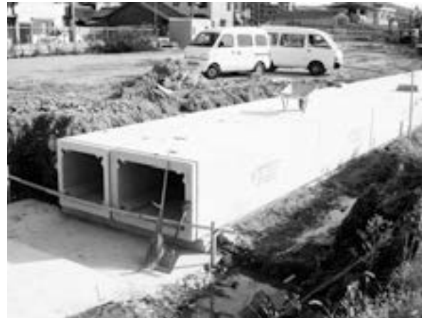
長尺PRCボックスカルバート (寸法900×800×4000mm, 1200×800×4000mm)
