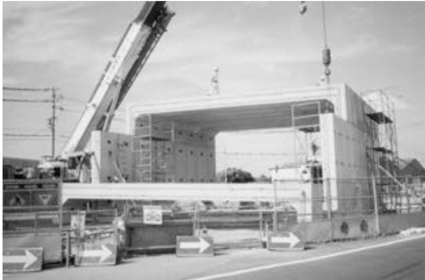
大型多分割ボックスカルバート（寸法9500×4900mm）
