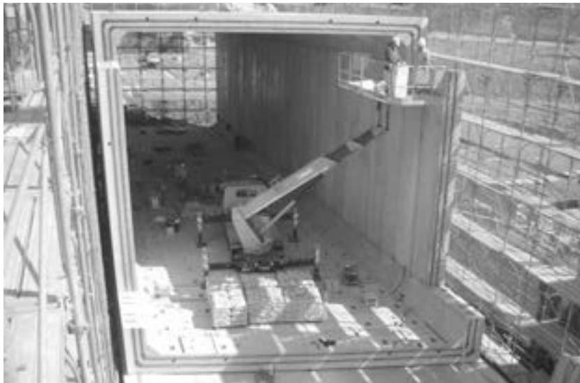
大型多分割ボックスカルバート（寸法9250×9000mm）
