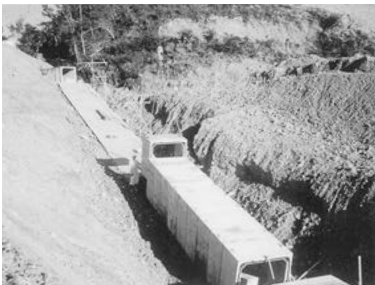
急勾配敷設ボックスカルバート
