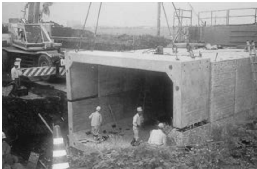
上下二分割ボックスカルバート（寸法5500×3300mm）
