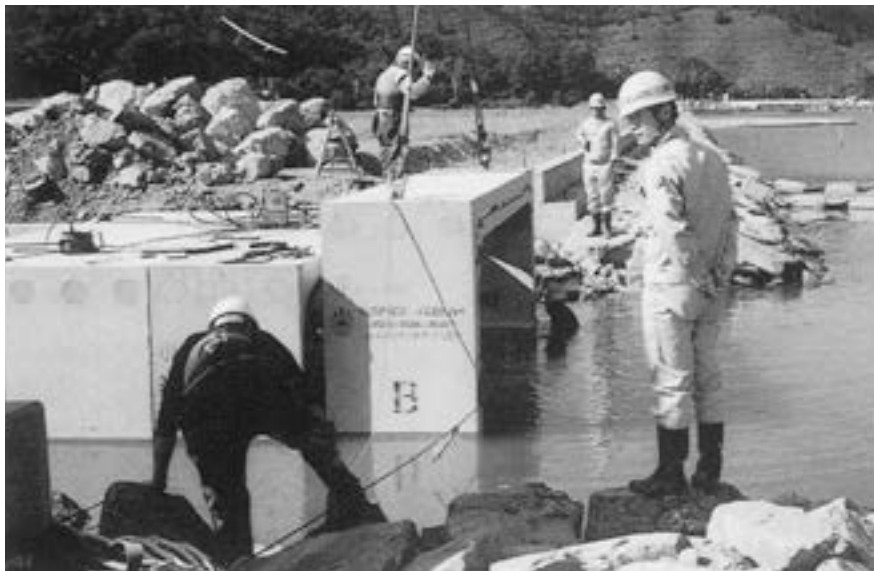
海中施工ボックスカルバート
