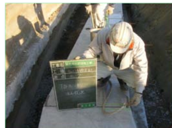
頂版部の注入口より側壁部・底版部へ注入 (曲線部)
