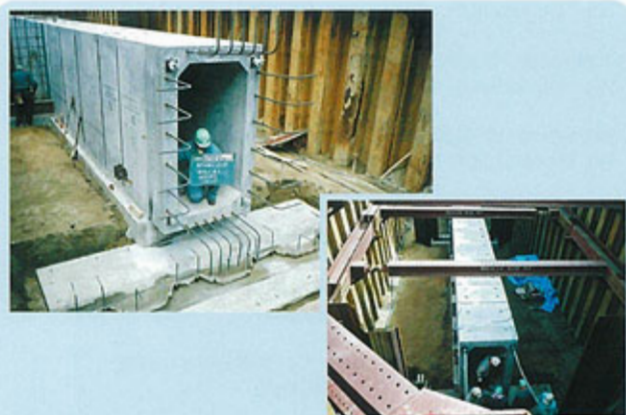
施主 香川県 長尾土木事務所 工事名 鴨部川改修工事 B×H 1000×2000
