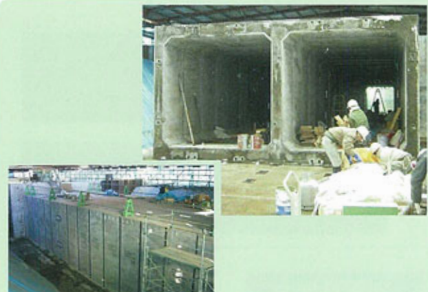
施主 北海道開発局 石狩川開発建設部 千歳河川事務所 工事名 志文別樋門（石狩川水系千歳川） B×H (3000+3000)×3000
