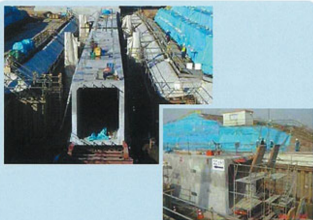
施主 国土交通省 関東地方整備局 利根川上流工事事務所 工事名 邑楽樋門第二排水樋管改築工事 B×H 3200×3200
