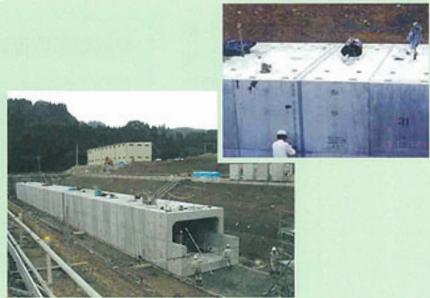
施主 国土交通省 東北地方整備局 岩手工事事務所 工事名 坂田排水樋門新設工事 B×H 4000×2600
