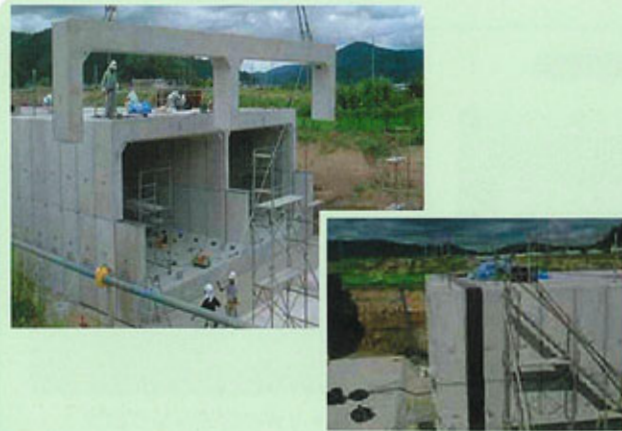
施主 国土交通省 近畿地方整備局 福知山工事事務所 工事名 尾藤川樋門築造工事 B×H (5800+5800)×4000
