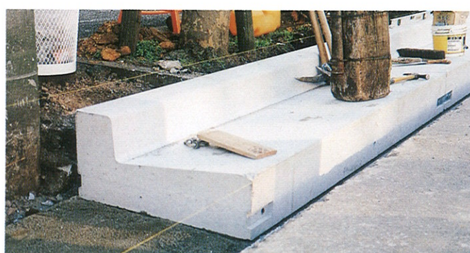
⑤プレキャスト街きよ据付け (転圧)
