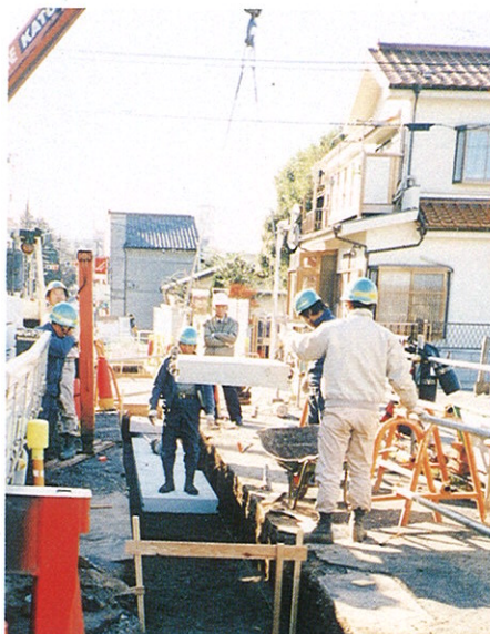
②ベースブロック吊り降し
