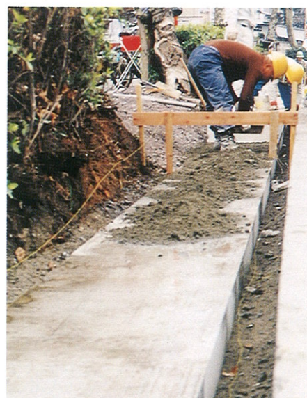
③ベースブロック据付け
