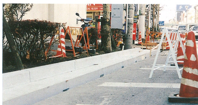
⑦据付け完了
