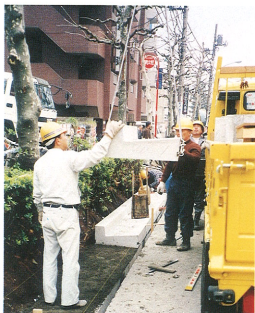
④プレキャスト街きよ吊り降し
