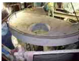
中間床版据付
