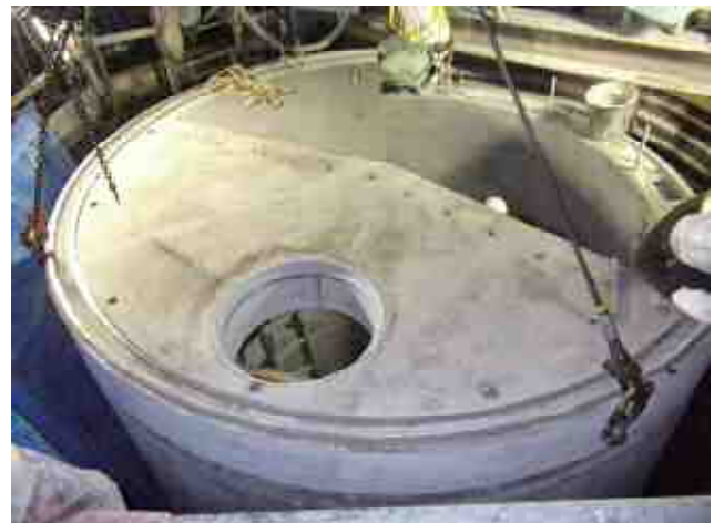
多段式中間床版（耐摩耗板埋め込み）方式
