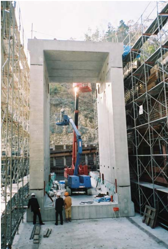
平成16年度 箕面北部丘陵地区教育施設用地等造成工事 放流渠 上下4分割ボックスカルバート 4200×9350×1500mm
