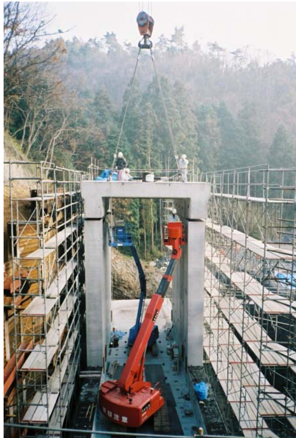
平成16年度 箕面北部丘陵地区教育施設用地等造成工事 放流渠 上下4分割ボックスカルバート 4200×9350×1500mm
