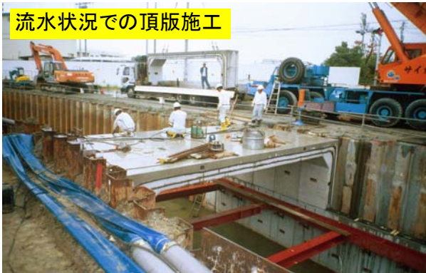
頂版を側壁へPC緊張で接合、施工後の状況
