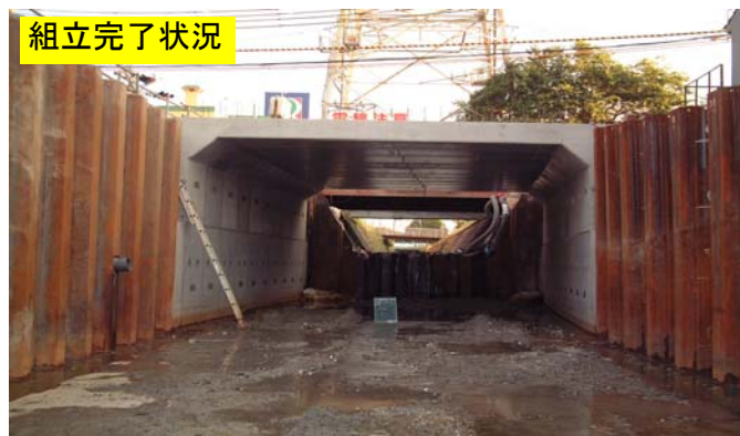
頂版を側壁へPC緊張で接合、施工後の状況
