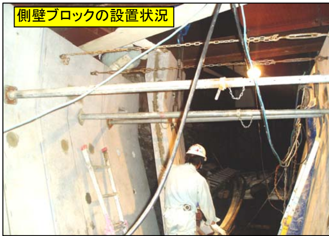
側壁ブロックの設置状況
