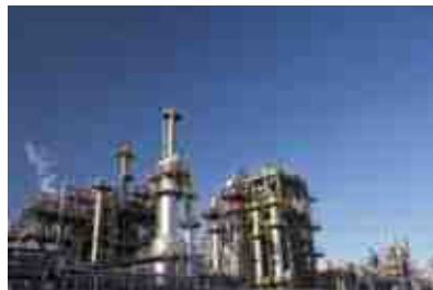
工場(施設)排水後に
