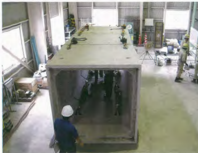
曲線施工試験 (IB50 タイプ)
