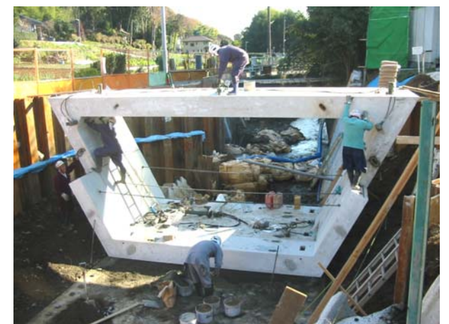
6. 緊張組立て状況
