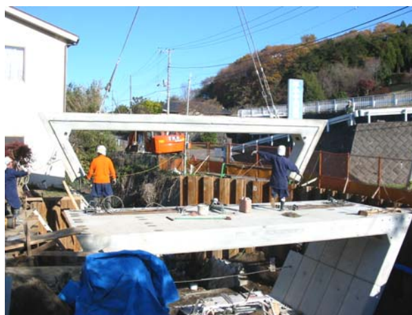
5. 吊り降ろし状況
