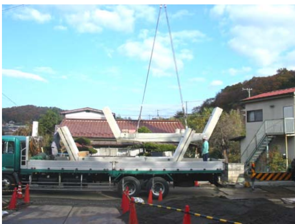
1. 荷取り状況（下部）
