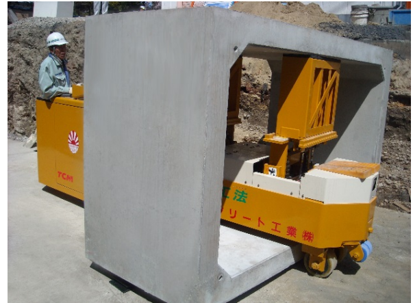
【ECO-C・L工法による搬送・据付】
