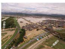
⑤ 小田川における浸水被害 (岡山県倉敷市)
