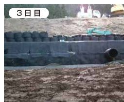
大型土のう+アデム巻き込みによる応急復旧
