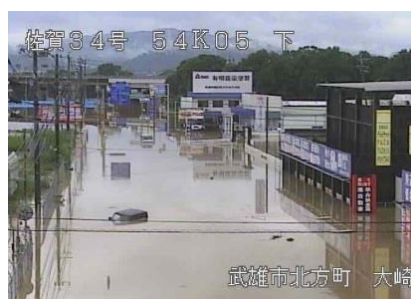
出水時の状況 国道34号（佐賀県武雄市）
