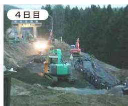
大型土のう+アデム巻き込みによる応急復旧
