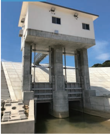
電動式ステンレス製ローラーゲート (ピンラック式)
