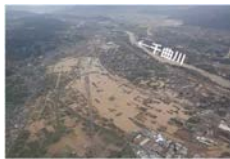
⑨ 千曲川における浸水被害状況 (長野県長野市)
