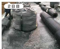
大型土のう+アデム巻き込みによる応急復旧
