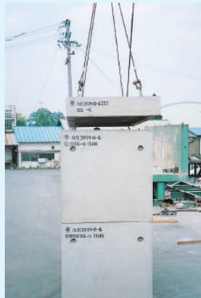
④スラブ・直壁据付
