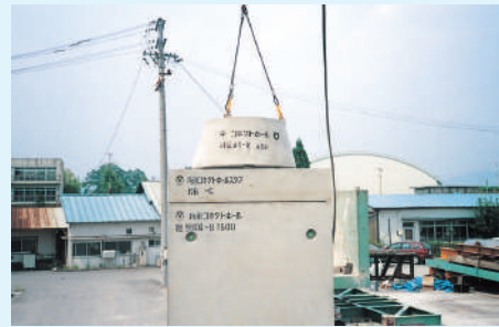
⑤円形1号斜壁据付
