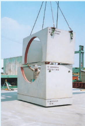
③直壁据付
