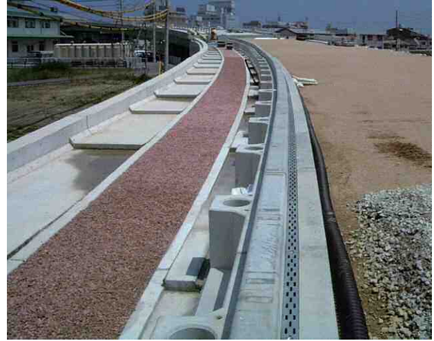
特殊施工例 歩車道境界部への利用
