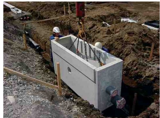
通信接続枱設置
