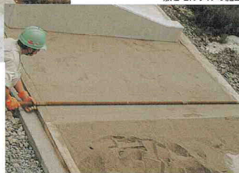
敷きモルタルの施工
