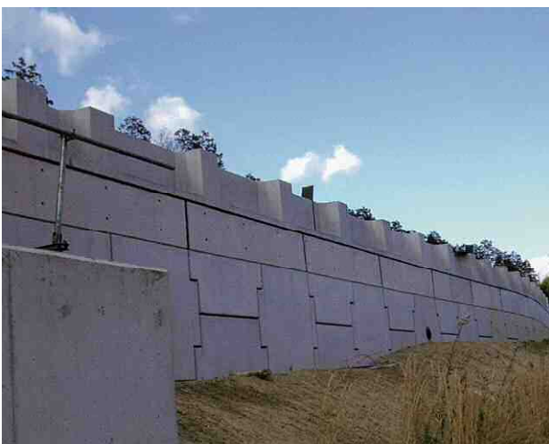
補強土壁直上
