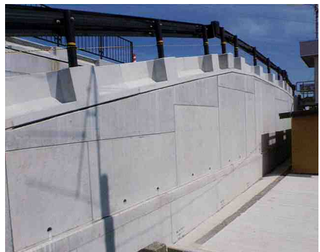
急激勾配変化部 (超軽量盛土上)
