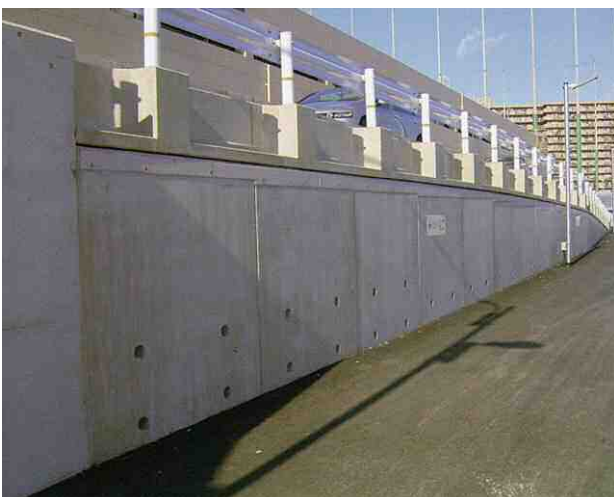
プレキャストL型擁壁直上
