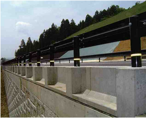
補強土壁直上
