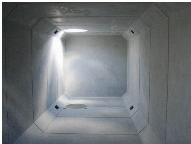
狭隘型40m 3 内部の状況
