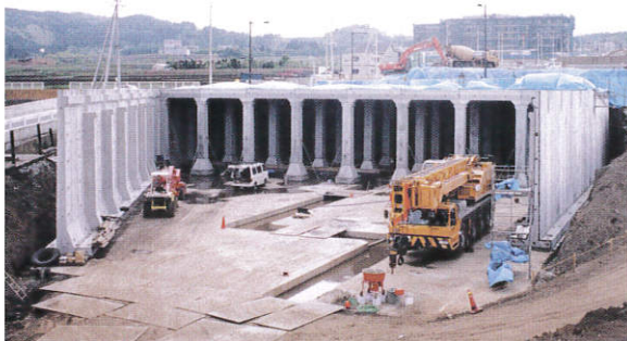
組立作業状況
