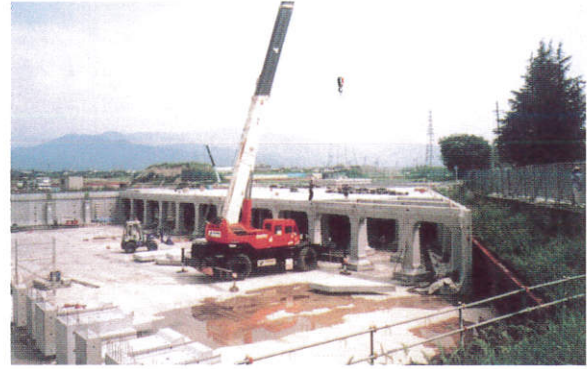
組立作業状況
