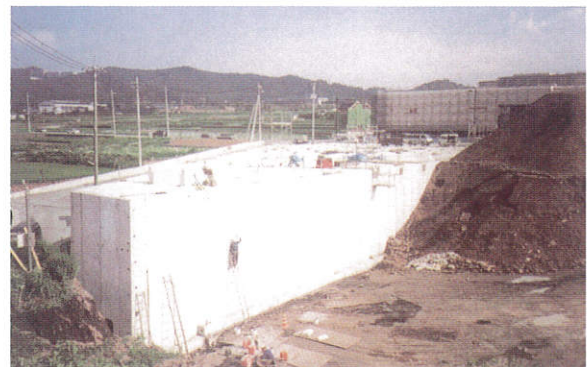
組立完成状況
