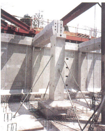
柱・梁据付け状況
