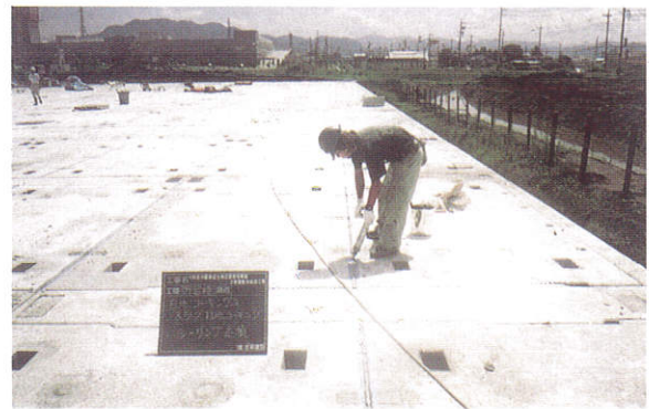
組立完成状況
