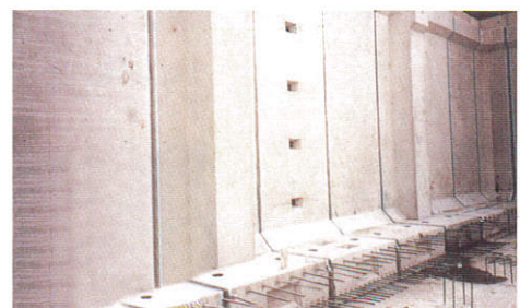
壁据付け状況
