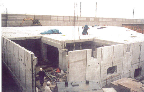
組立作業状況
