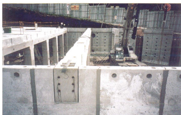
梁据付け状況
