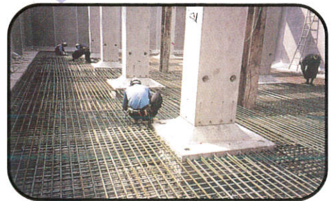
6. 底盤部鉄筋組立
