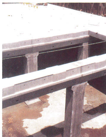
頂版スラブ据付け状況
