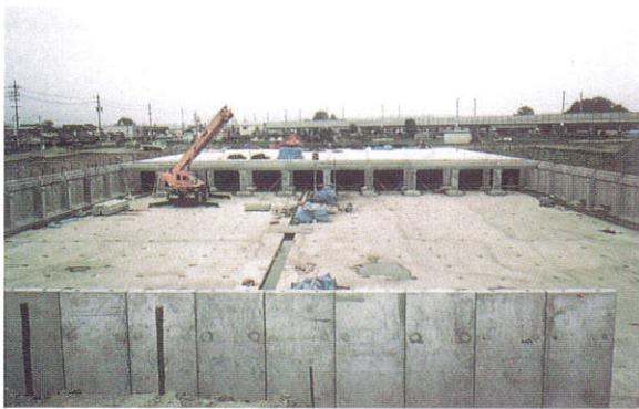
組立作業状況
