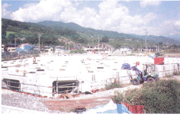
組立完成状況
