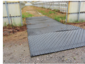
ビニールハウス入口養生
