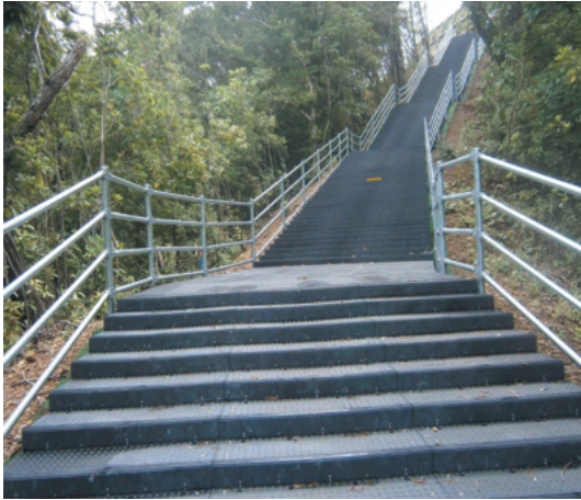
津波避難路階段 ジオ・ステップワイド W=3,000mm幅 (W=1,000mm品×3枚横連結/踊場設置)/高知県土佐市
