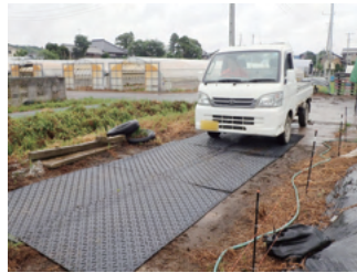
軽トラの通路養生
