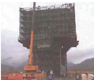
橋架の橋脚表面
