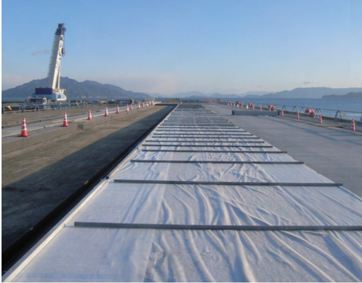
港湾エプロン舗装養生中
