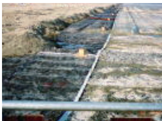
土砂敷き均し作業
