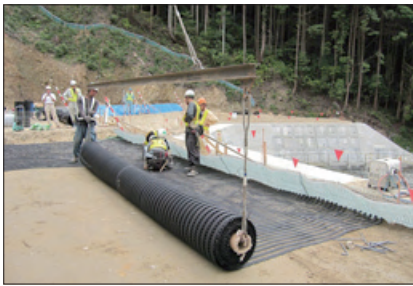
補強土壁工法(全体安定)
