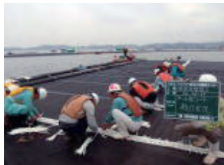
ジョイント作業
