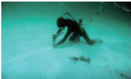
水中ジョイント作業
