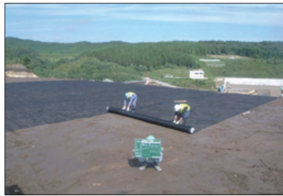
補強盛土工法
