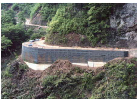
補強土壁工法(FW工法)
