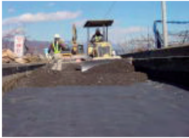
路盤補強・分離
