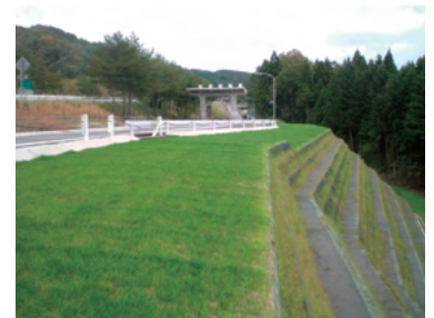
強化本復旧完了
