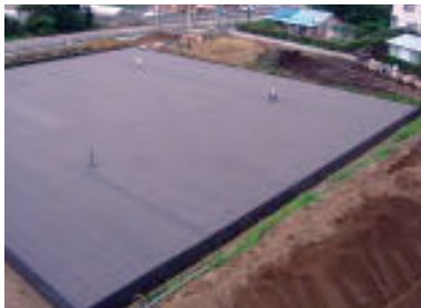
雨水浸透貯留施設
