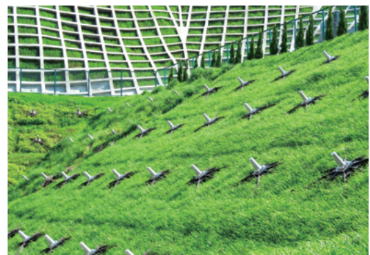
緑化状況 (施行後)
