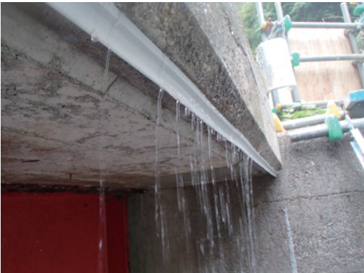
構造物底にウォーターカッター設置した状況
