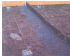
ハシピタン敷設状況
