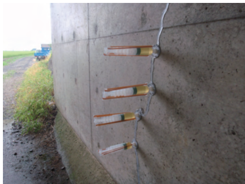
CRBインジェクターを用いた注入補修状況
