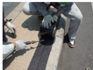
シール貼付け
