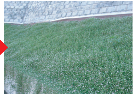
1年経過写真 雑草の繁茂も無く、ヒメイワダレソウが被覆し緑化される。
