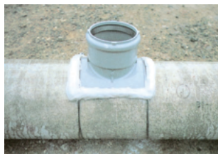
ヒューム管と塩ビ支管の固定状況
