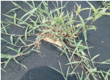
悪い例 防草シートカット後、直接の植栽により苗が死滅し雑草が繁茂下状況。
