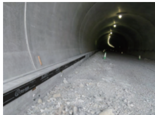
コンクリート舗装側目地の目地板(ケンタイト)借固定に使用
