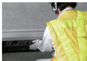
ケンタイト貼り付け状況
