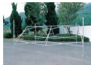
④ 屋根を固定する
