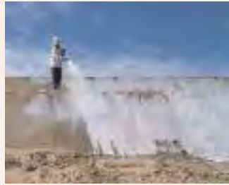
【施工条件】 ・法面 ・スーパーS 250g/㎡使用 (法面半年設定濃度)
