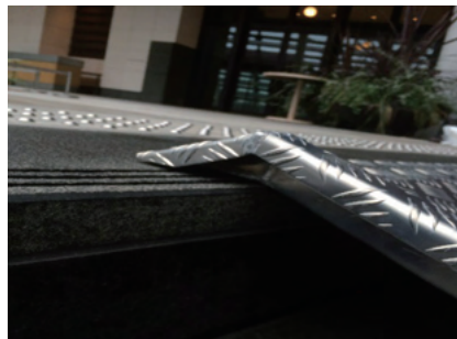
段差最上部に引っ掛けるだけ(10cm)
